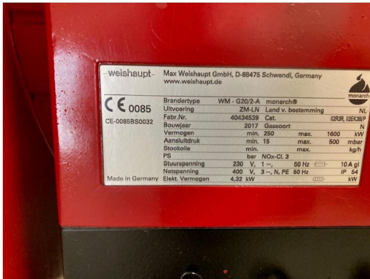
Foto 19 Kenplaat stoomketel brander. Betreft een Weishaupt LN brander. LN staat voor LowNox.
