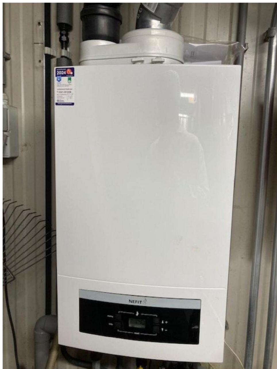
Foto 12 CV ketel technische dienst voor ruimteverwarming Nefit Proline NxT HRC 24/ CW4 Installatiejaar 2023. Productiejaar is 2022.
