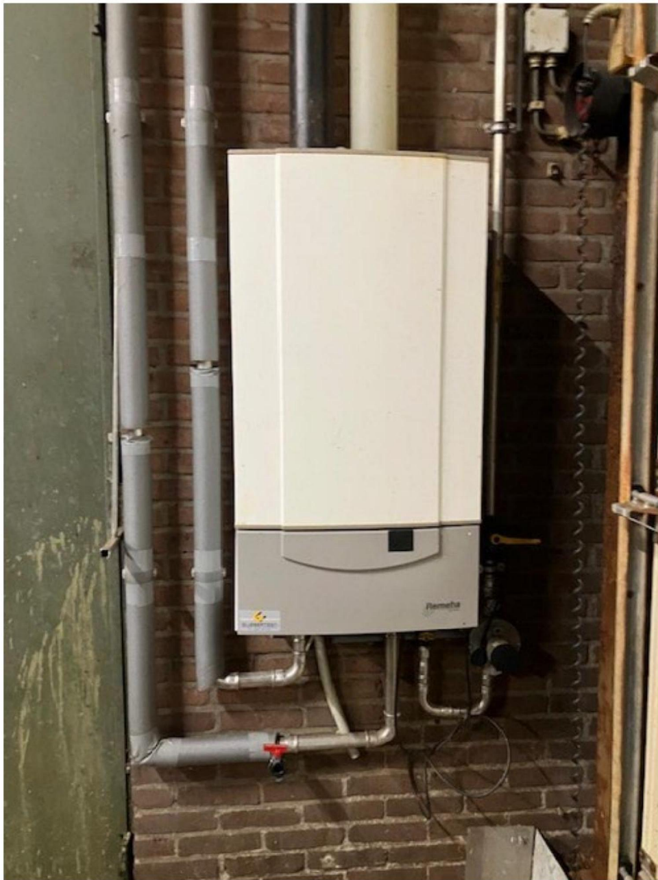
Foto 8 Buiten gebruik zijnde installatie, cv ketel kantoren
