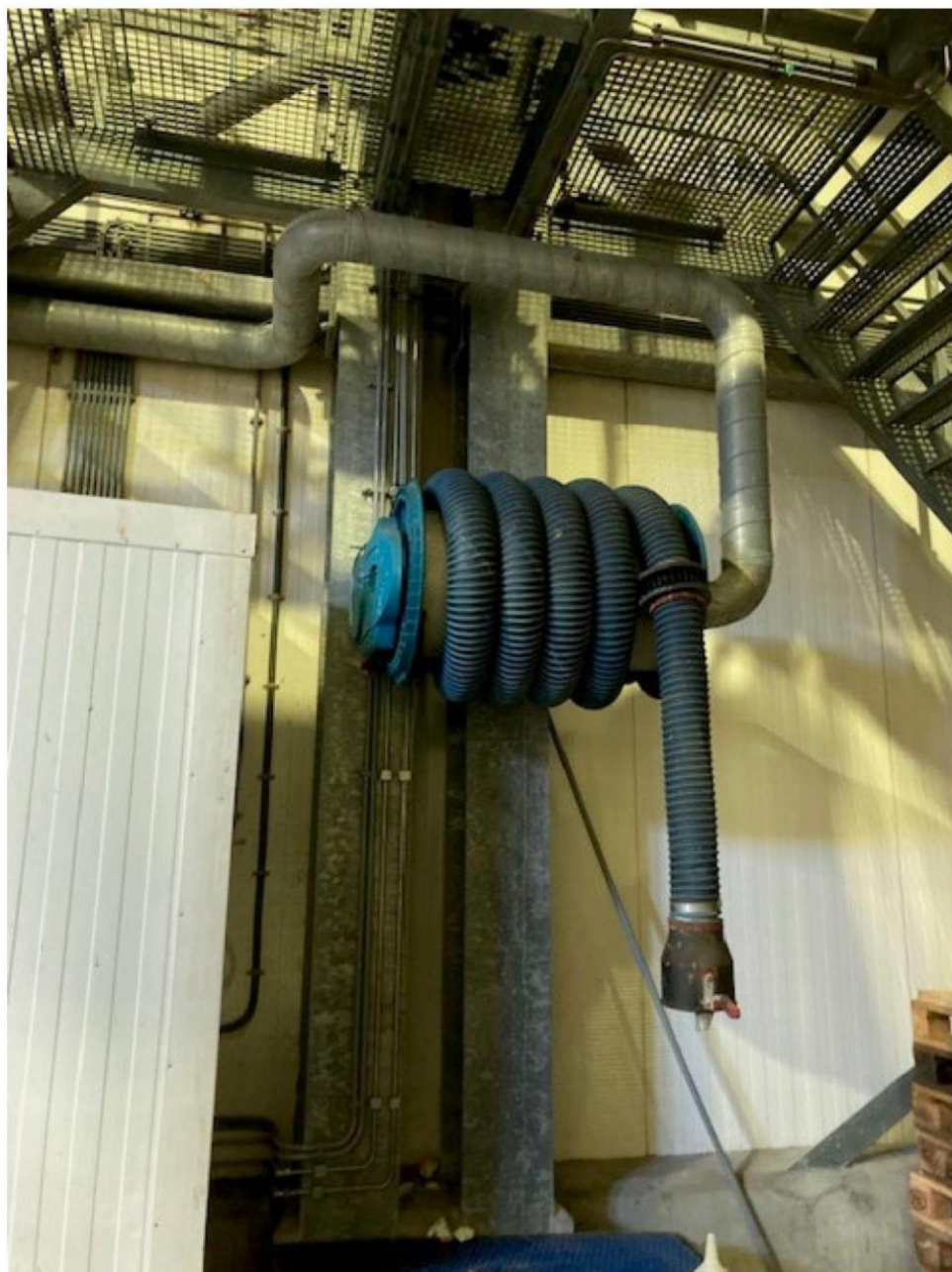
Foto 15 Afzuiging reinigingshal. Slang is bedoeld om emissies van voertuigen af te voeren bij draaiende motor
