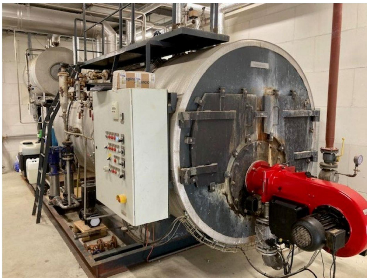
Foto 18 Geplaatste stoomketel in september 2024, betreft verplaatste installatie vanuit locatie Halvikhuizerweg zoals beschreven in aanvraag Natuur.
