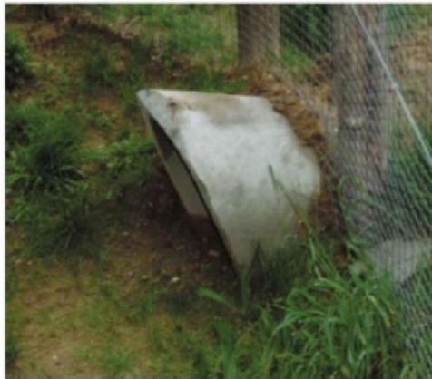
Figuur 18: door het schuine uiteinde zal er minder snel inregenen (bron: Handreiking faunavoorzieningen bij wegen)
