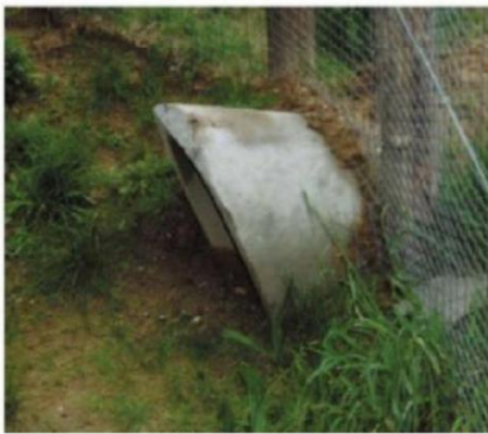
Figuur 18: door het schuine uiteinde zal er minder snel inregenen (bron: Handreiking faunavoorzieningen bij wegen)
