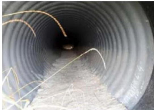
Een laag zand maakt tunnels aantrekkelijker voor dieren (Bron: 5.1.2e RWS)
