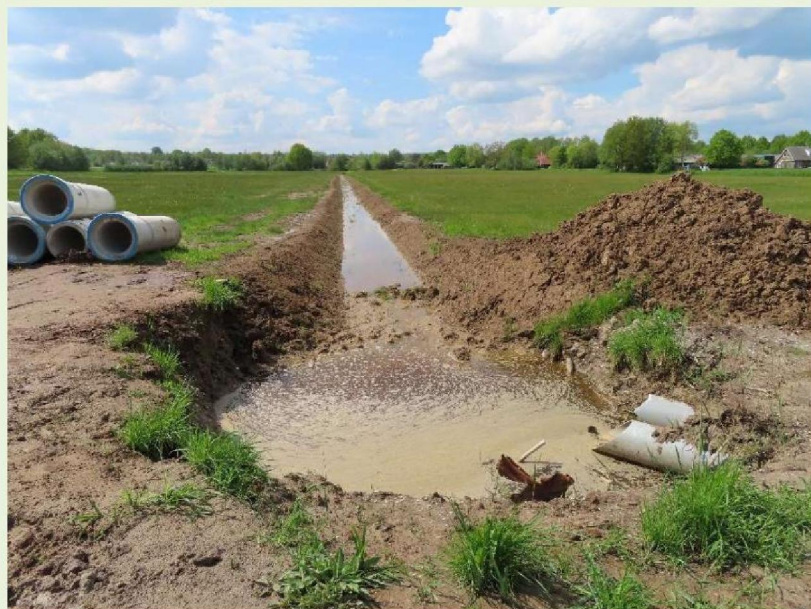
Locatie 8b (haaks op 8a): beleemde sloot, in verband met afvoer uit achterliggend gebied is sloot gehandhaafd. Beleming van de sloot zorgt er voor dat kwel niet wordt afgevangen door de sloot.
