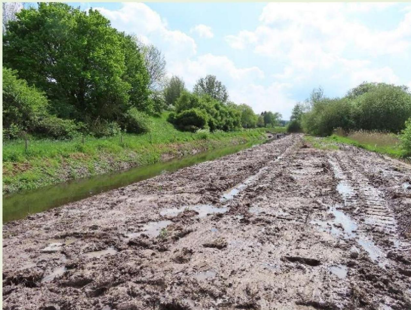
Locatie 8a: sloot langs vuilstort verbreed en verondiept.
