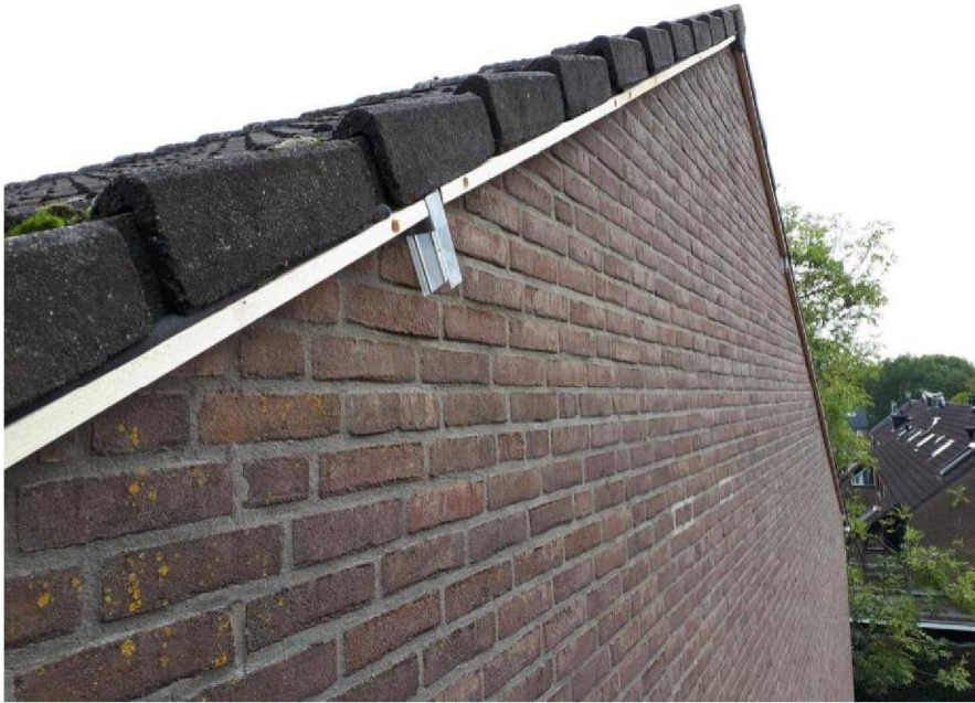
Detail exclusion flaps met panlatten en rugvulling.
