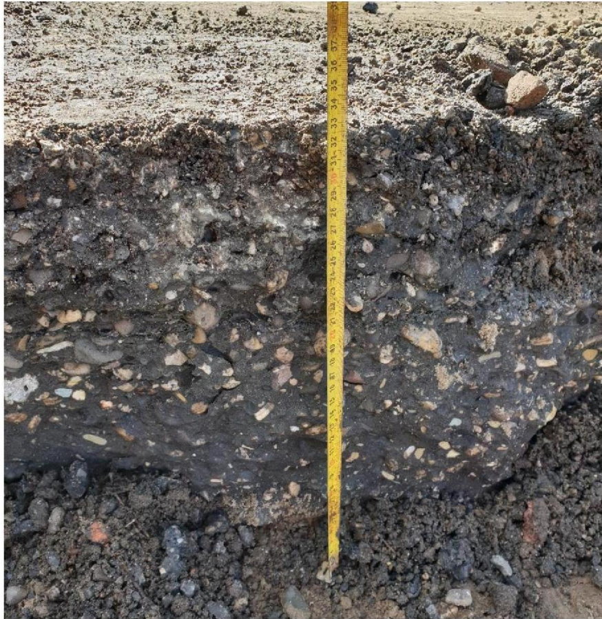
De dikte van het asfalt valt op een aantal plekken flink tegen.
