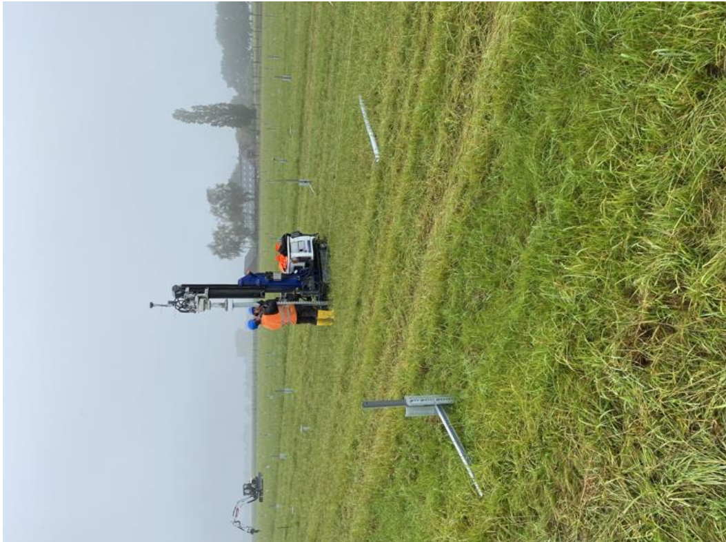
Aanlegwerkzaamheden heien fundering zonnepanelen -5 - 18-09-2023 13:59
