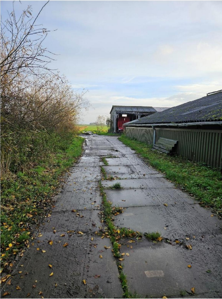
Foto: pad betonplaten tussen stallen. Golfplaten dak met dakgoot en afwatering
