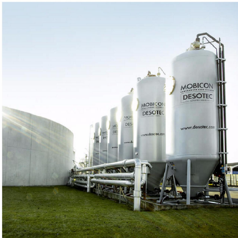
Afbeelding 3: Waterzuivering door mobiele actieve koolfilters https://www.desotec.com/nl/
