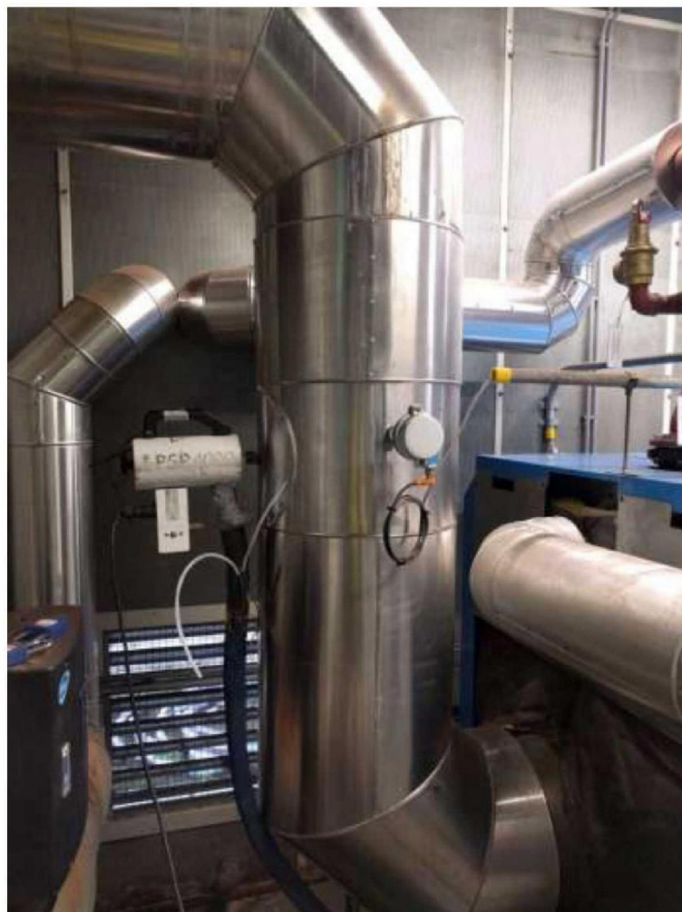
Foto 1b: Meetvlak stortgasketel bij ARN te Weurt.
