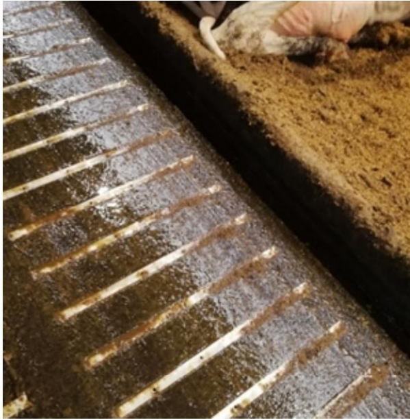
Voorbeeld van een roostervloer met inlays met urineafvoergaatjes in de roosterspleten
