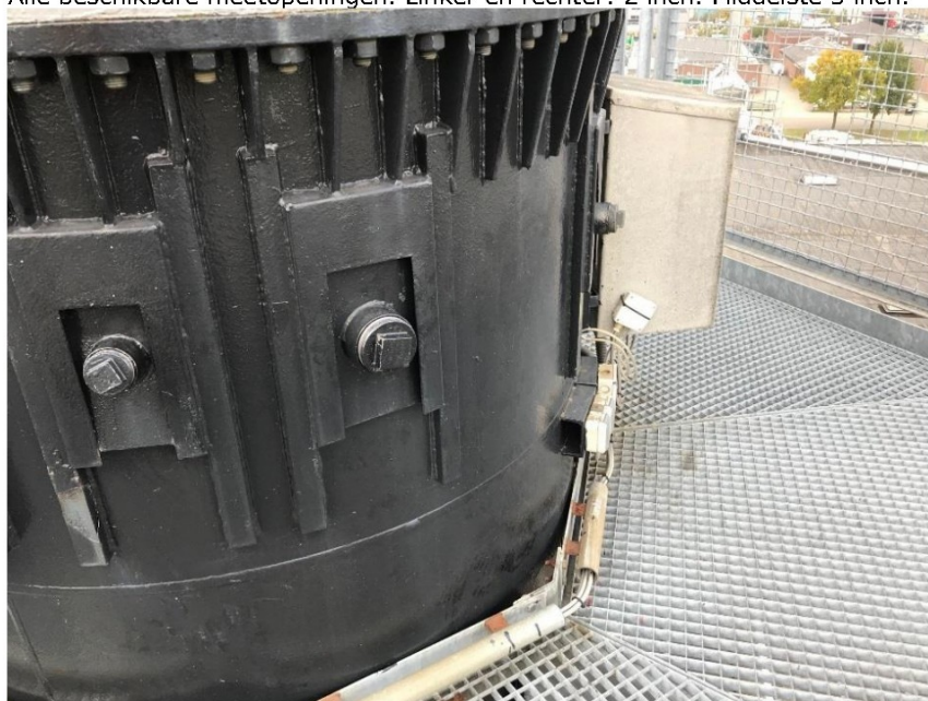
Foto 1c: Meetvlak centrale schoorsteen NIJG te Nijmegen d.d. 26 oktober 2021. Alle beschikbare meetopeningen. Linker en rechter: 2 inch. Middelste 3 inch.
