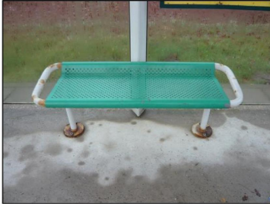
Links: roestvorming op zitelement
