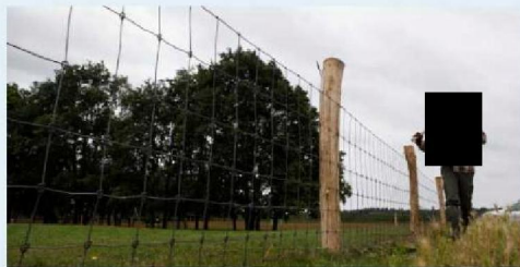
Stichting Wolf-Fencing Nederland heeft fladderlinten en wolfwerende rasters met stroomdraden geplaatst bij de schaapskool van Epe © BU12.
