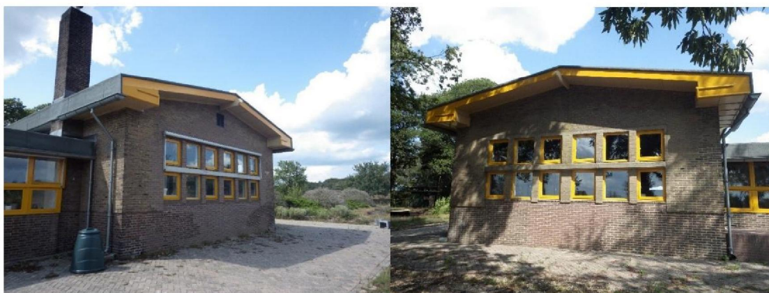
Figuur 6. Aanzicht boeiboorden gebouw C en E
