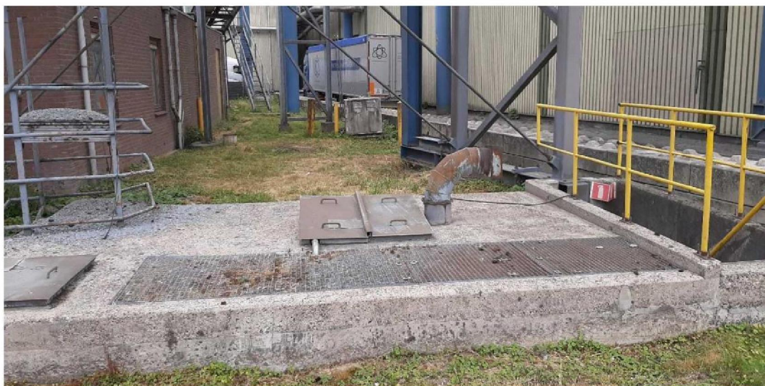
Foto Oude meetkelder met aan de linkerzijde het luik van de effluent put
