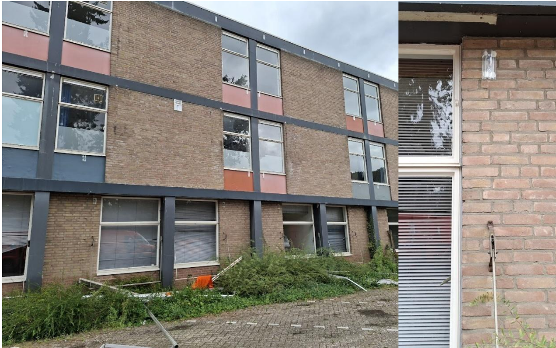
Figuur 2.2 Links een overzichtsfoto van de gevel met exclusionflap. Rechts een uitsneden van een locatie waar de zonweringsbediening naar binnen ging en aan de buitenzijde is voorzien van een exclusionflap.
