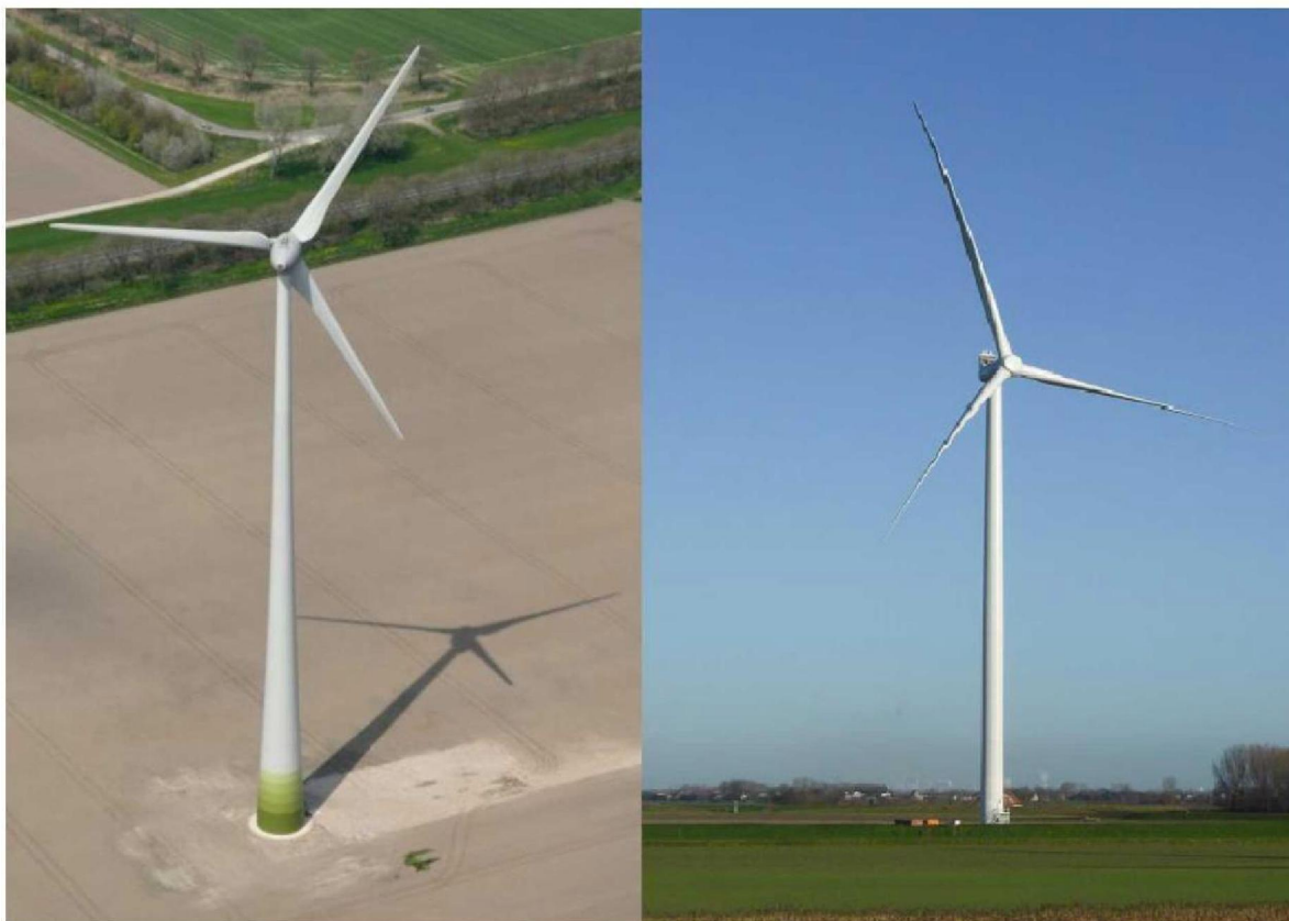
Figuur 4.1 Windturbines met een betonnen of stalen mast *)
