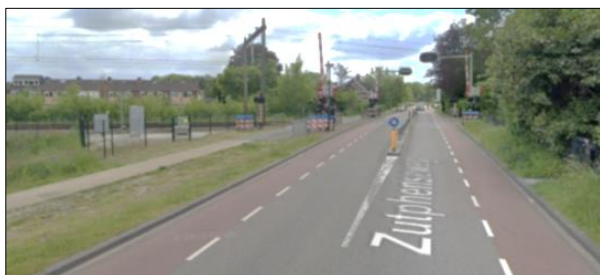
Afbeelding 25: Bestaande situatie spoorwegovergang
