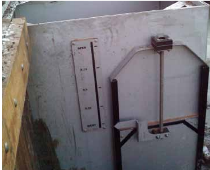
Figuur 1 - Met spindel regelbare schuif op het bovenstroomse venster. Bron: B. Tolkamp Ecogroen.
