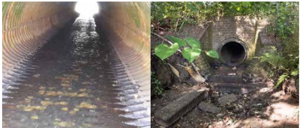
Figuur 1 - Duiker met een te hoge stroomsnelheid over een te lang traject (links) en een duiker met een slechte aansluiting op de bodem (rechts). Bron: Ecogroen (foto links) & Waterschap de Dommel (foto rechts)
