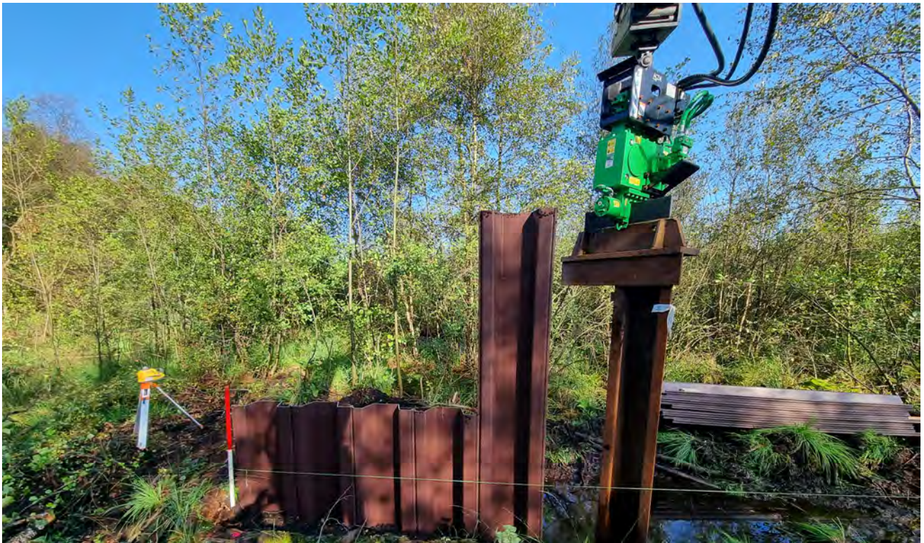
Plaatsen damwand in hoogveengebied
