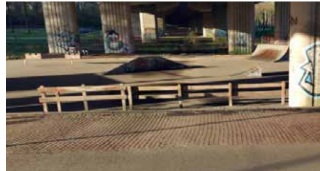
Afbeelding 27. Situatie zuidzijde viaduct, skateparkje met te vervangen hekwerk
