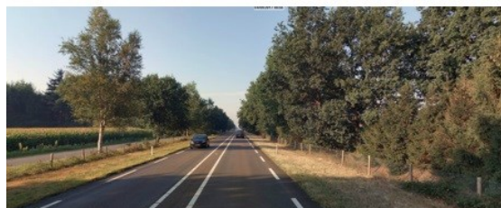
3: verbreding rijbaan en fietspad
