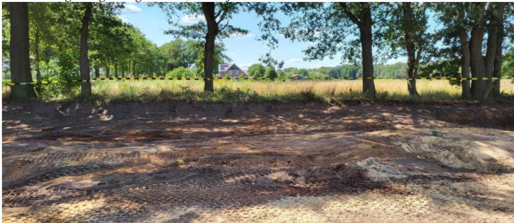
Foto 3: ontgraving overige terrein, zuidelijk deel
