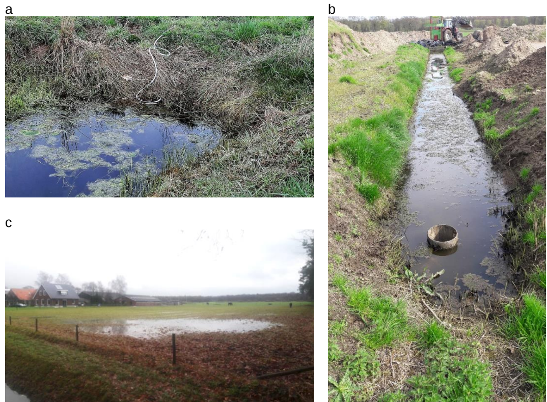
Figuur 2.6 a: opgezet slootpeil door een duiker met afsluitbal (opblaasslangetje zichtbaar), b: opzetstuk op duiker bij de erfsloot, c: natte omstandigheden met plasvorming op het laaggelegen westelijke deel van het bedrijf in de winter van 2018.
