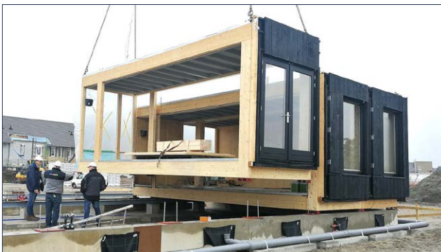
Modulaire houtbouw door architectenbureau SeARCH en aannemersbedrijf De Groot Vroomshoop. Bron: SeARCH
