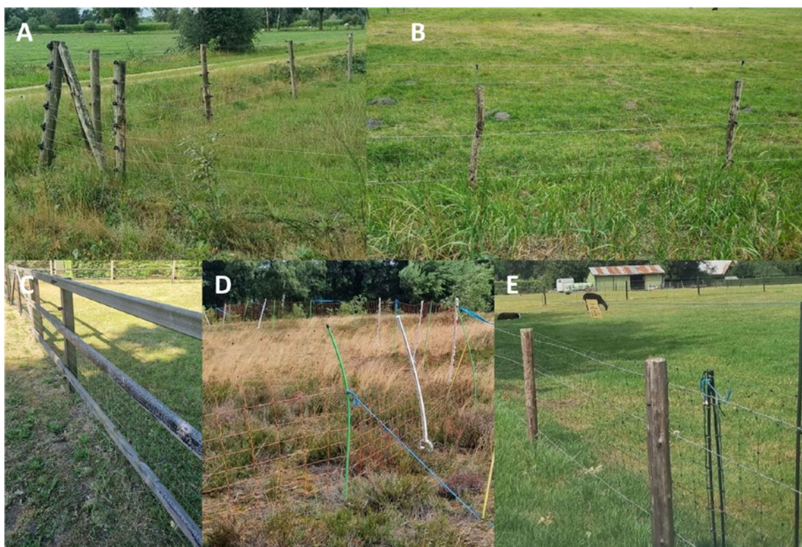
Figuur 3. Mogelijk wolfwerende rasters. A: Stroomdraden. B: Gaas met stroomdraad. C: Balken met gaas en stroomdraad. D: Flexinet. E: Flexinet met stroomdraad
