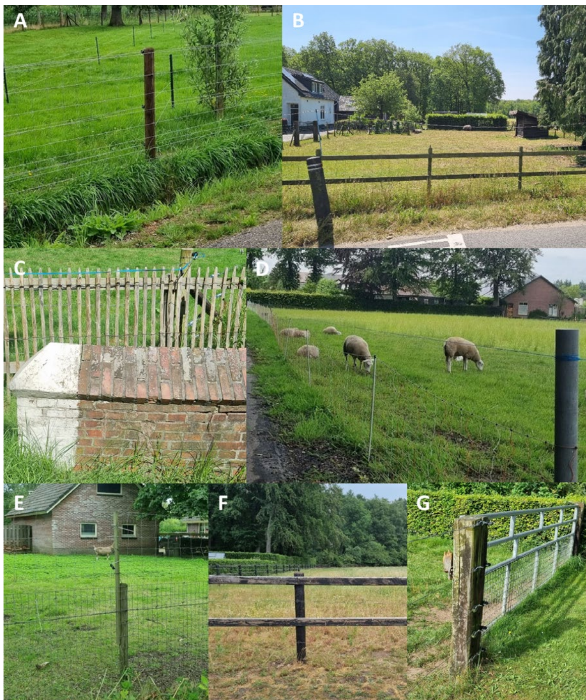
Figuur 4. Verschillende gebreken bij pogingen tot het wolfwerend maken van rasters. A: Stroomdraden aan de binnenkant. B: Enkel hoog stroomdraad. C: Opstapmogelijkheden. D: Afstand tussen de palen te groot. E: Verhoogd raster. F: Afstand tussen de draden te groot.
