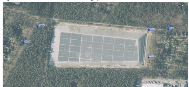
figuur 1: locatie met monitoringspeilbuizen
