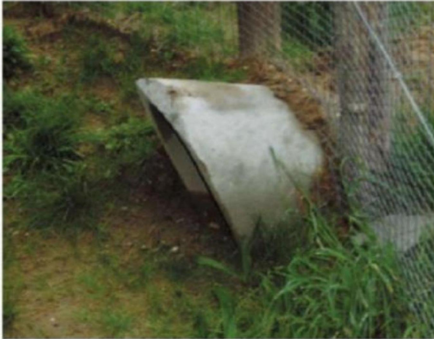
Figuur 5.2 Dassentunnel met schuine uiteinde zodat het minder snel inregent (bron: Handreiking faunavoorzieningen bij wegen).
