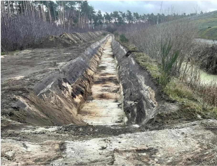
Foto 1: noodoverstort met overlaat
