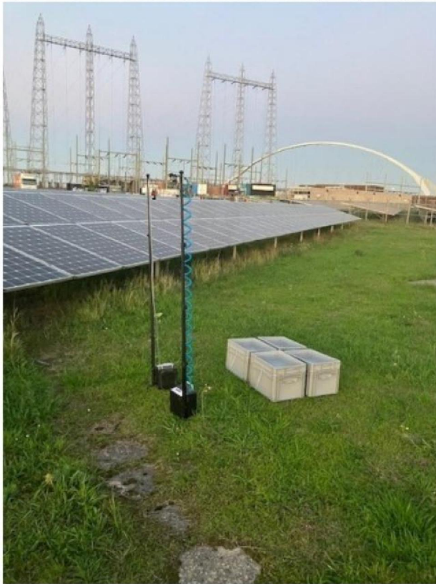
Figuur 2.2 PDT-Sombakken en twee luchtpompen ingezet door sloopbedrijf.
