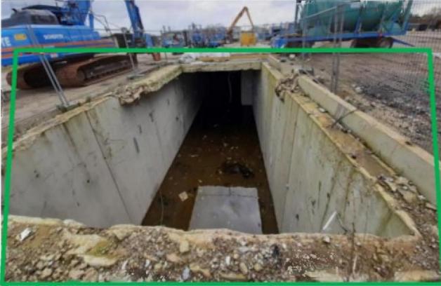
Foto.1: Kelder voormalige biomassa opslagsilo's en opvoertransportband
