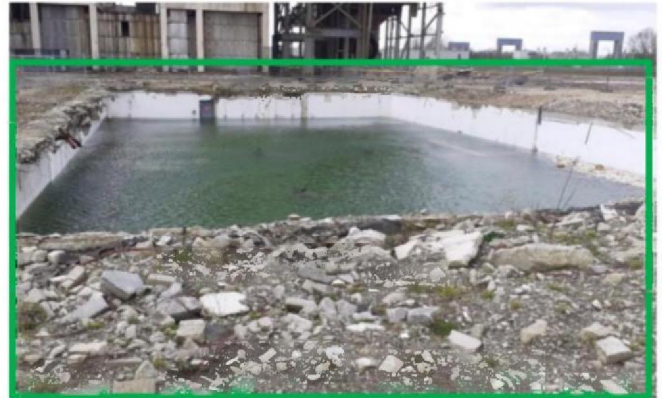
Foto 2: Kelder onder voormalig dienstengebouw
