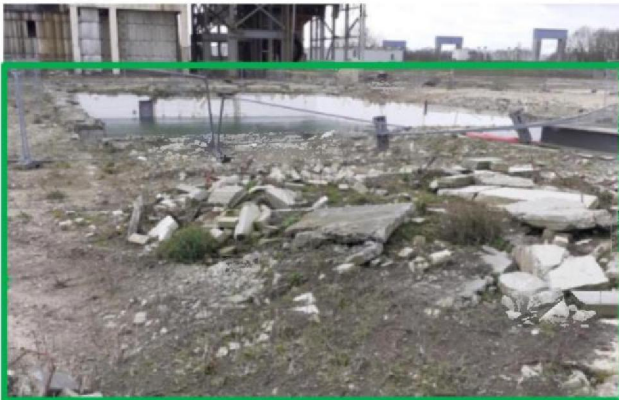
Foto 1: Kelder onder voormalig dienstengebouw
