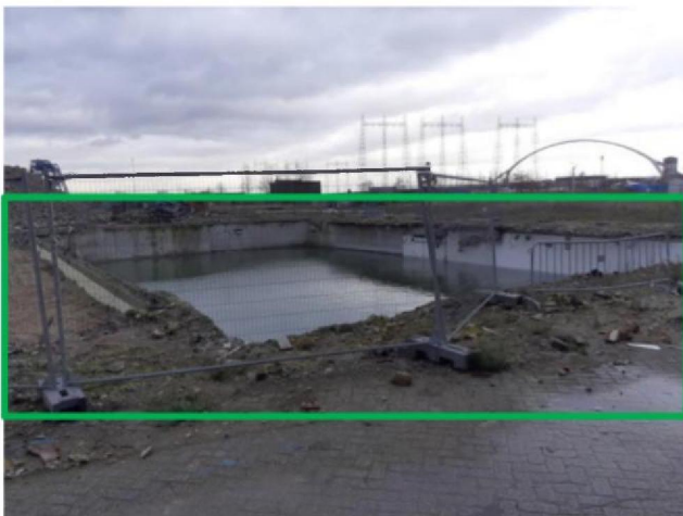
Foto 3: Kelder onder voormalig dienstengebouw
