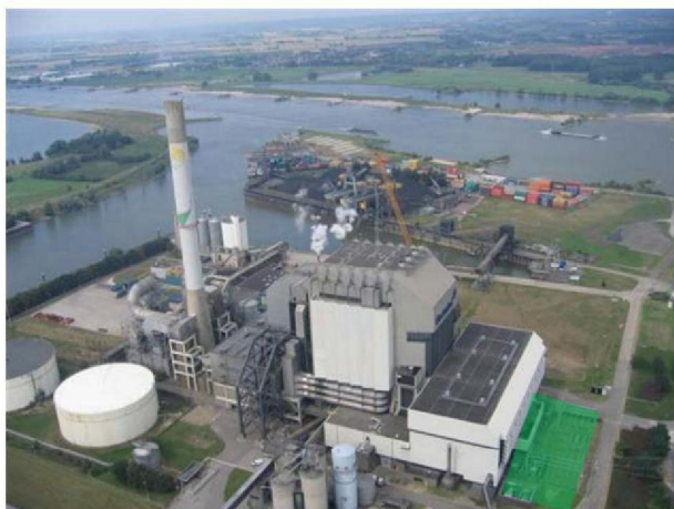
Z4L45.1: Hoogspanning trafotuin G13
