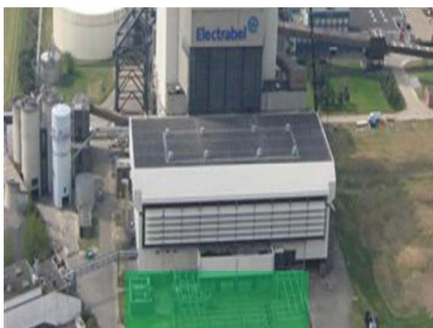
Z4L45.3: Hoogspanning trafotuin
