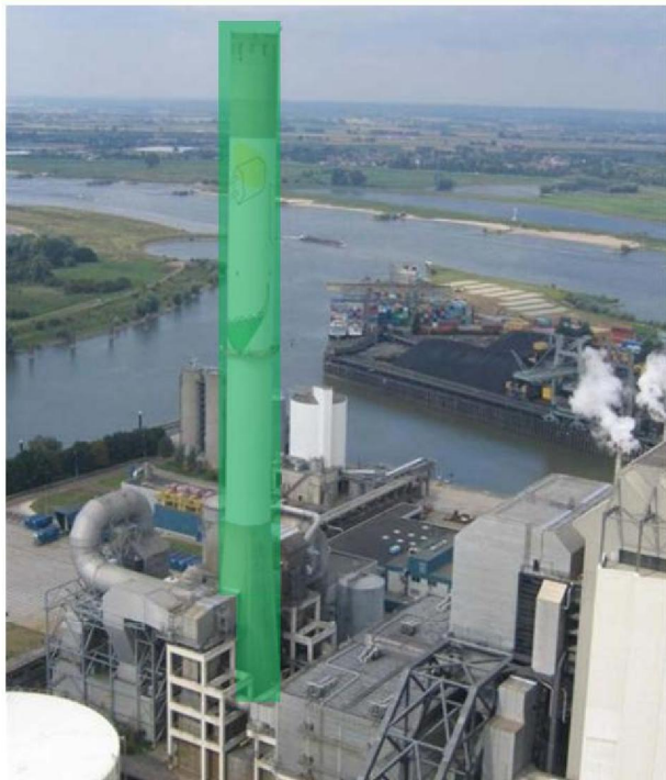
Z8L22.1: noord gevel schoorsteen
