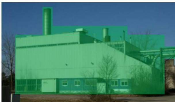
Z7L21.1: hulp- en snelstartketel gebouw
