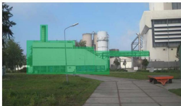
Z7L21.2: hulp- en snelstartketel gebouw
