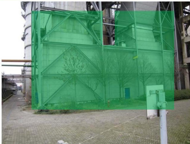
Z6L28D.1: zuid gevel ventilatorgebouw
