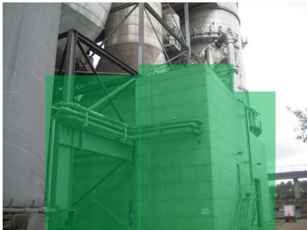
Z6L28B.1: noord gevel pompenhalgebouw ROI
