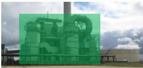
Z6L28A.1: overzicht west gevel cluster 6, Lot 28A
