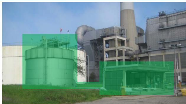
Z8L40.2: ammoniatank en ammoniagebouw
