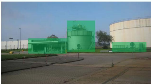
Z8L40.1: overzicht (links naar rechts) ammoniagebouw, ammoniaopslag en ondergrondse propaantank
