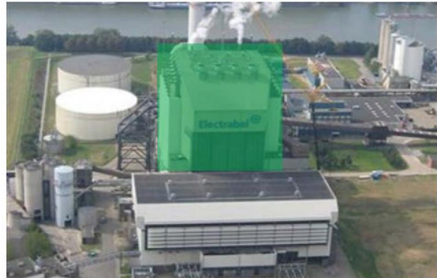
Z4L02.2: Ketelhuis oost gevel
