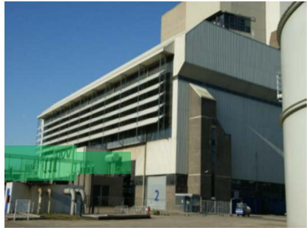
Z4L45.2: Hoogspanning trafotuin
