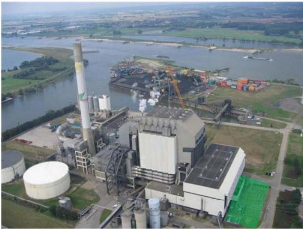
Z4L45.1: Hoogspanning trafotuin G13
