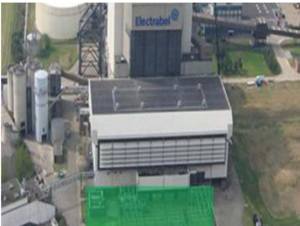
Z4L45.3: Hoogspanning trafotuin
