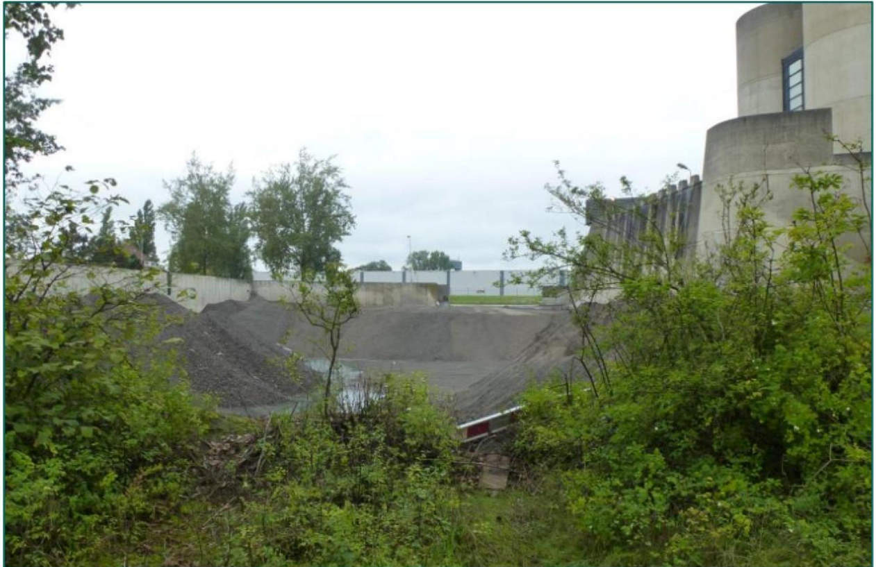
Figuur 14: Opslag bodemassen zuidelijk deel werkgebied (bron: ENGIE).
