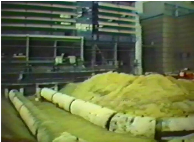
Figuur 15: Koelwateraanvoerleiding (bron: ENGIE).
