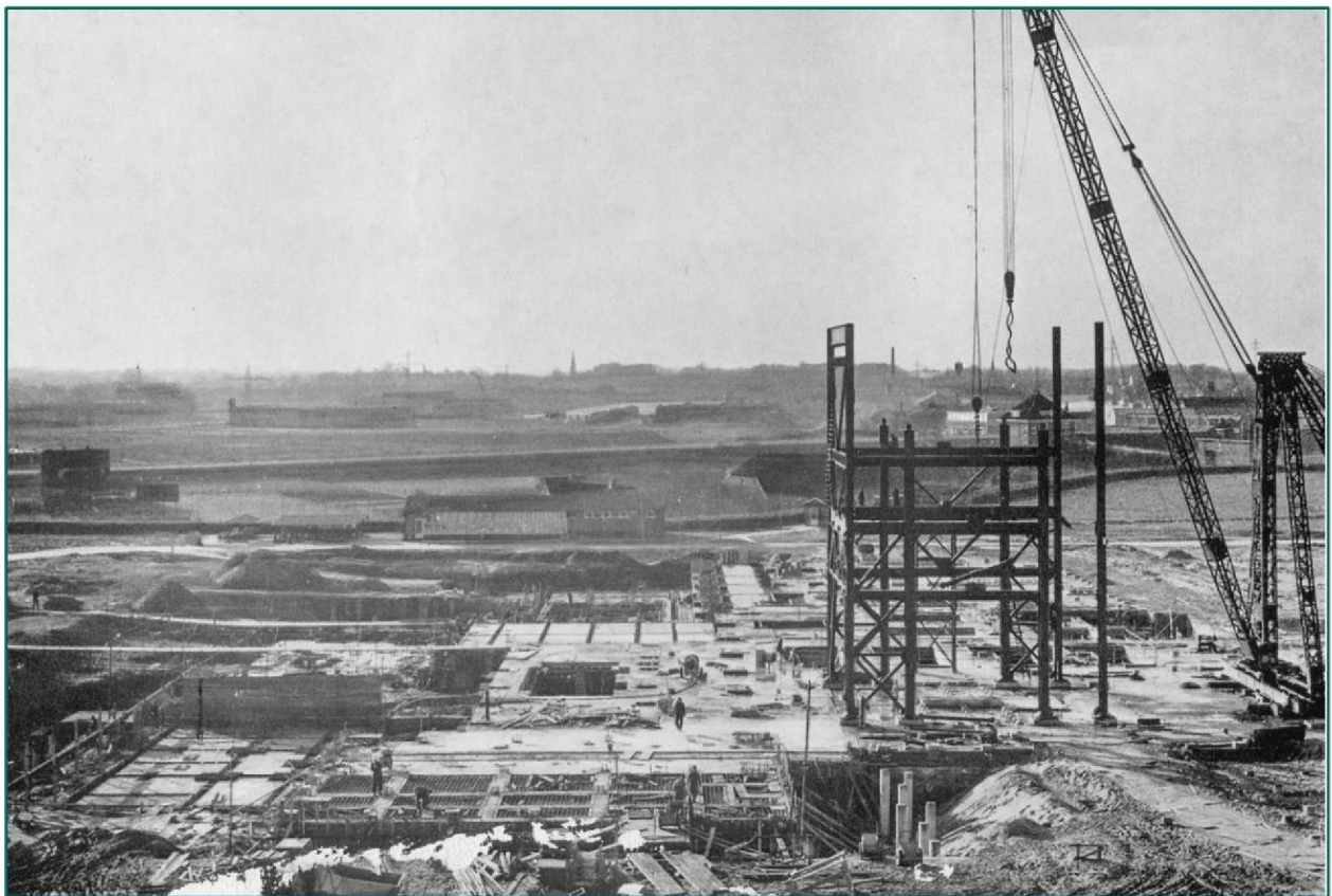
Figuur 12: Aanleg terrein Gelderland Zuid (bron: ENGIE).
