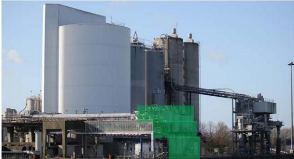
Z2L29.1: waterbehandelingsgebouw noordgevel
