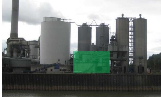
Z2L29.2: waterbehandelingsgebouw noordgevel
