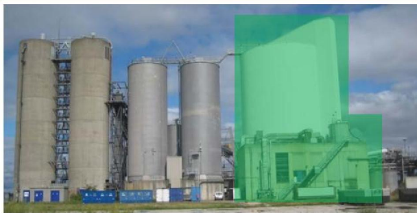
Z2L31.1: zuid gevel gipsbedieningsgebouw en centrifugegebouw
