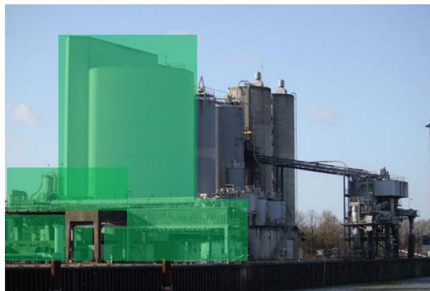
Z2L31.2: noord gevel gipsbedieningsgebouw en centrifuge gebouw
