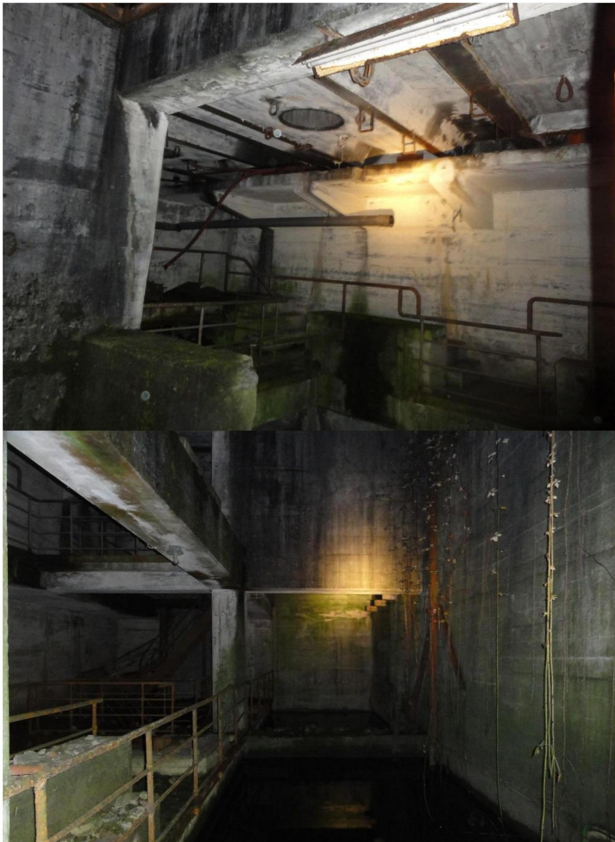
Figuur 4.3. Binnenzijde van kelder 2.
