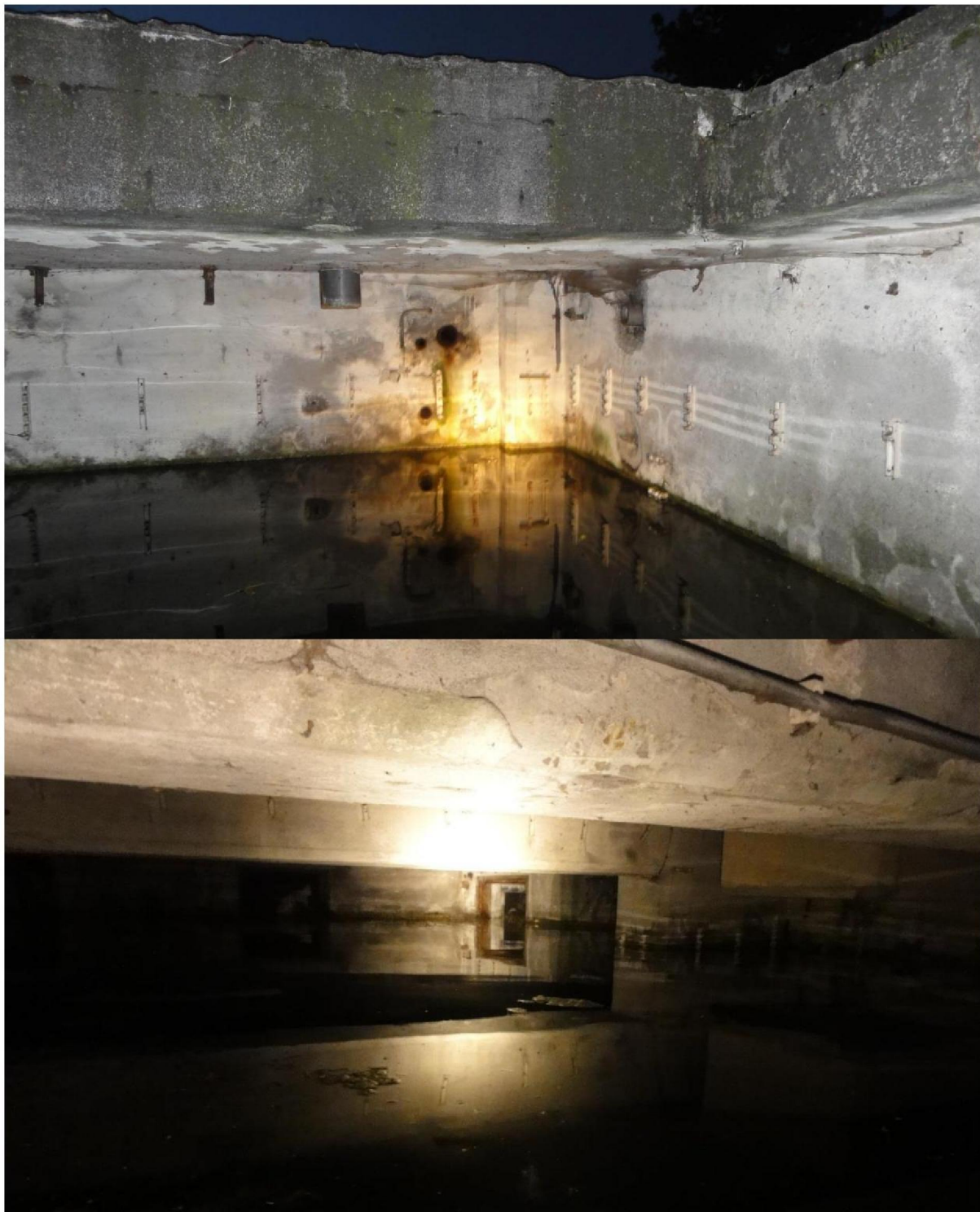
Figuur 4.5. Binnenzijde van kelder 3.
