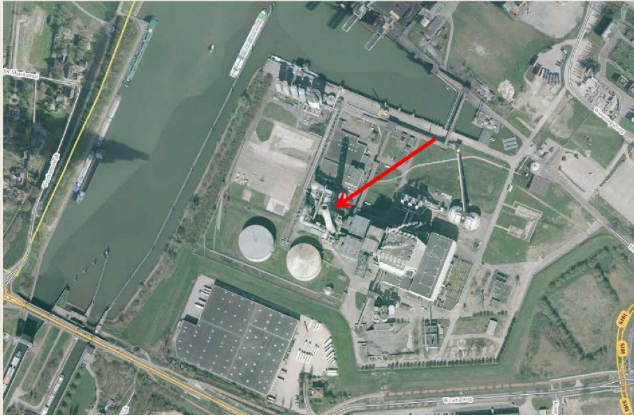
Huidige nestlocatie slechtvalk in de schoorsteen (rode pijl)
