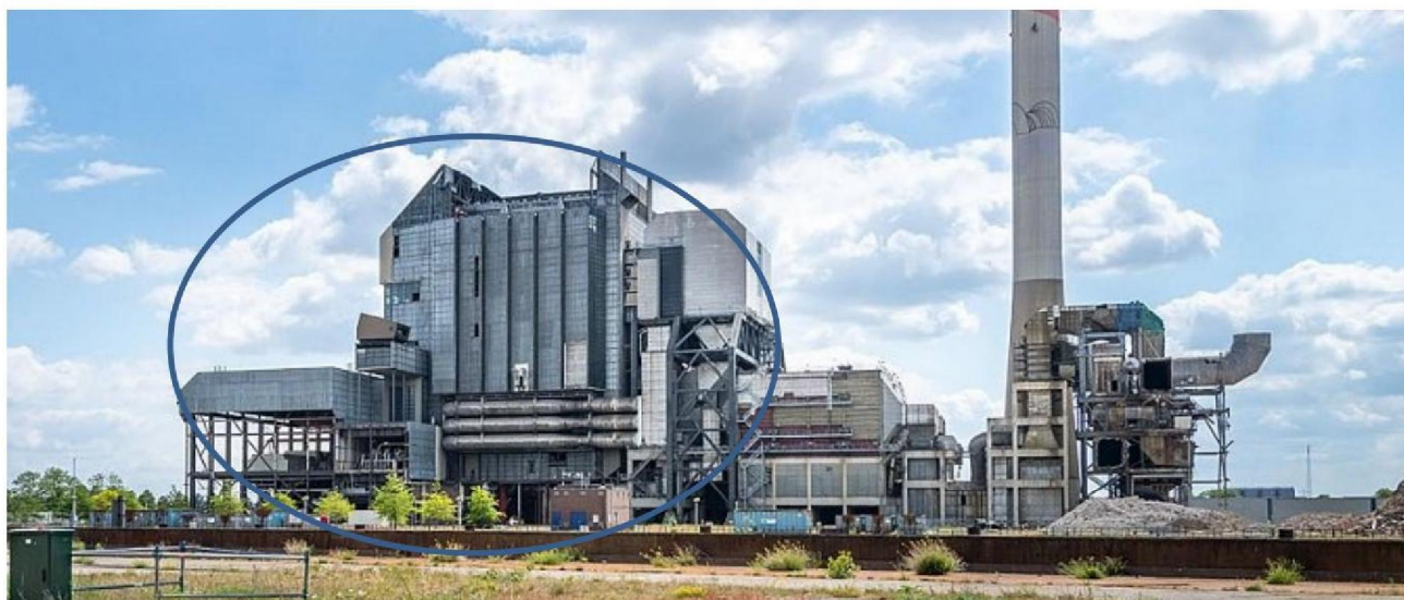
Afbeelding 1, overzicht installatie met het event in blauw ovaal aangegeven.
