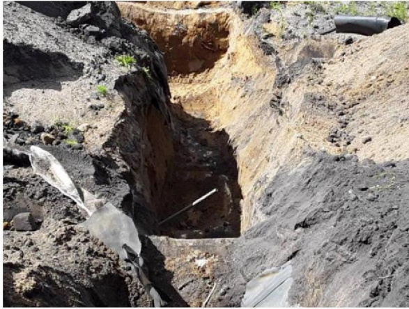
FB04: Overzicht van het vrij-gegraven profiel. In geen van de onderzochte constructiedelen zijn asbestverdachte materialen aangetroffen.
