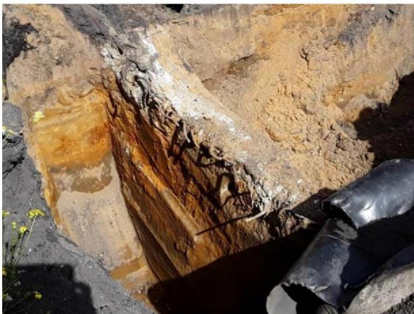
FB06: Tijdens de inspectie is de noordwand van de voormalige kolentunnel plaatselijk blootgelegd door middel van een graafmachine. Tijdens de inspectie zijn geen asbestverdachte materialen aangetroffen.
