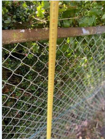
Hoogte omheining achterzijde.jpg
