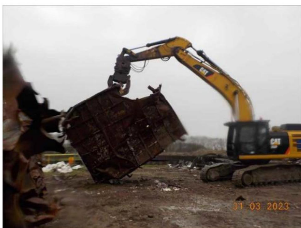
F9: Inspectie middels de kraan.
