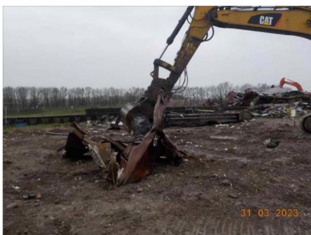
F7: Inspectie middels de kraan.
