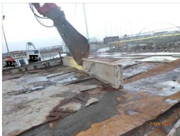
F12: Inspectie met behulp van de kraan.
