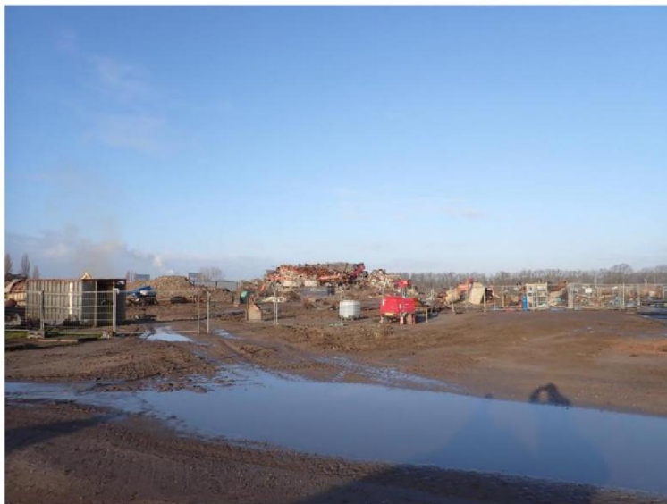
De kanalen van de Denox van de voormalige kolencentrale aan de Hollandiaweg 11 te Nijmegen
