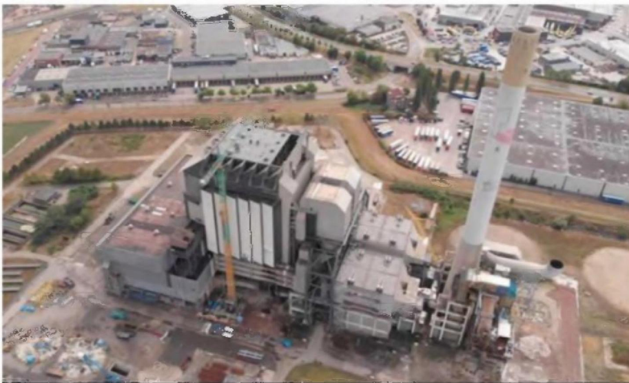
Figuur 2: Energiecentrale G13 tijdens sloop
