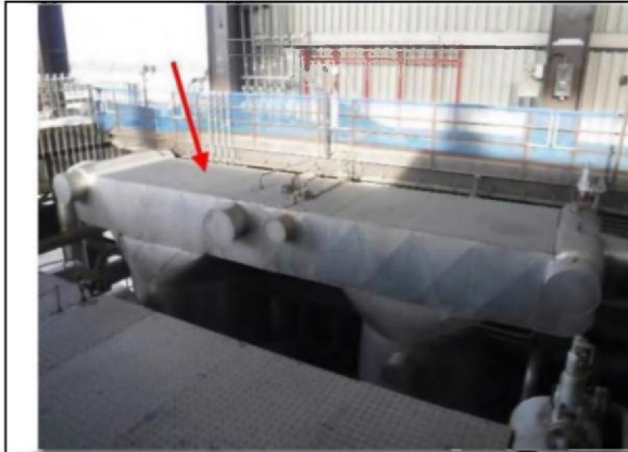
Foto 28 | Foto voor bron warmtebrug
