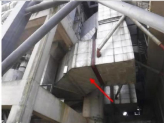
Foto 33 | Foto voor bron warmtebrug
