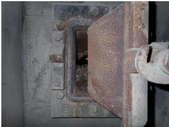
koordafdichting aanhechting luik op casing / constructie
