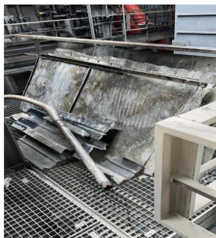
pakking warmtebrug level 68 meter
