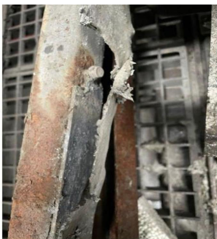
pakking warmtebrug level 68 meter
