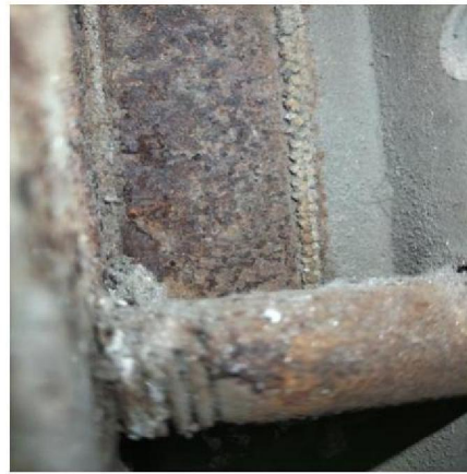
koordafdichting aanhechting luik op casing / constructie
